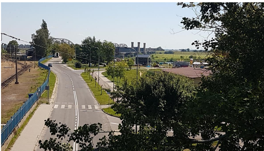
Widok na dwa mosty przez Wisłę, kolejowy i drogowy
